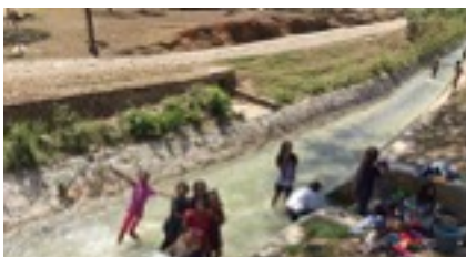
マリアナにある日本のODAで作られた水路
